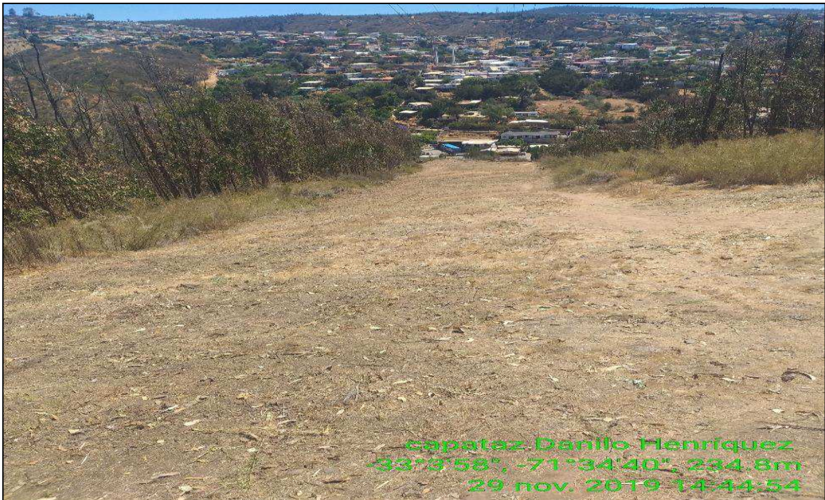
Figura 7: Franja de seguridad despejada de la Línea 110 kV Laguna Verde-Agua Santa vista desde la estructura N°45 hacia la estructura N°44. Tramo posterior a la zona del incendio.
