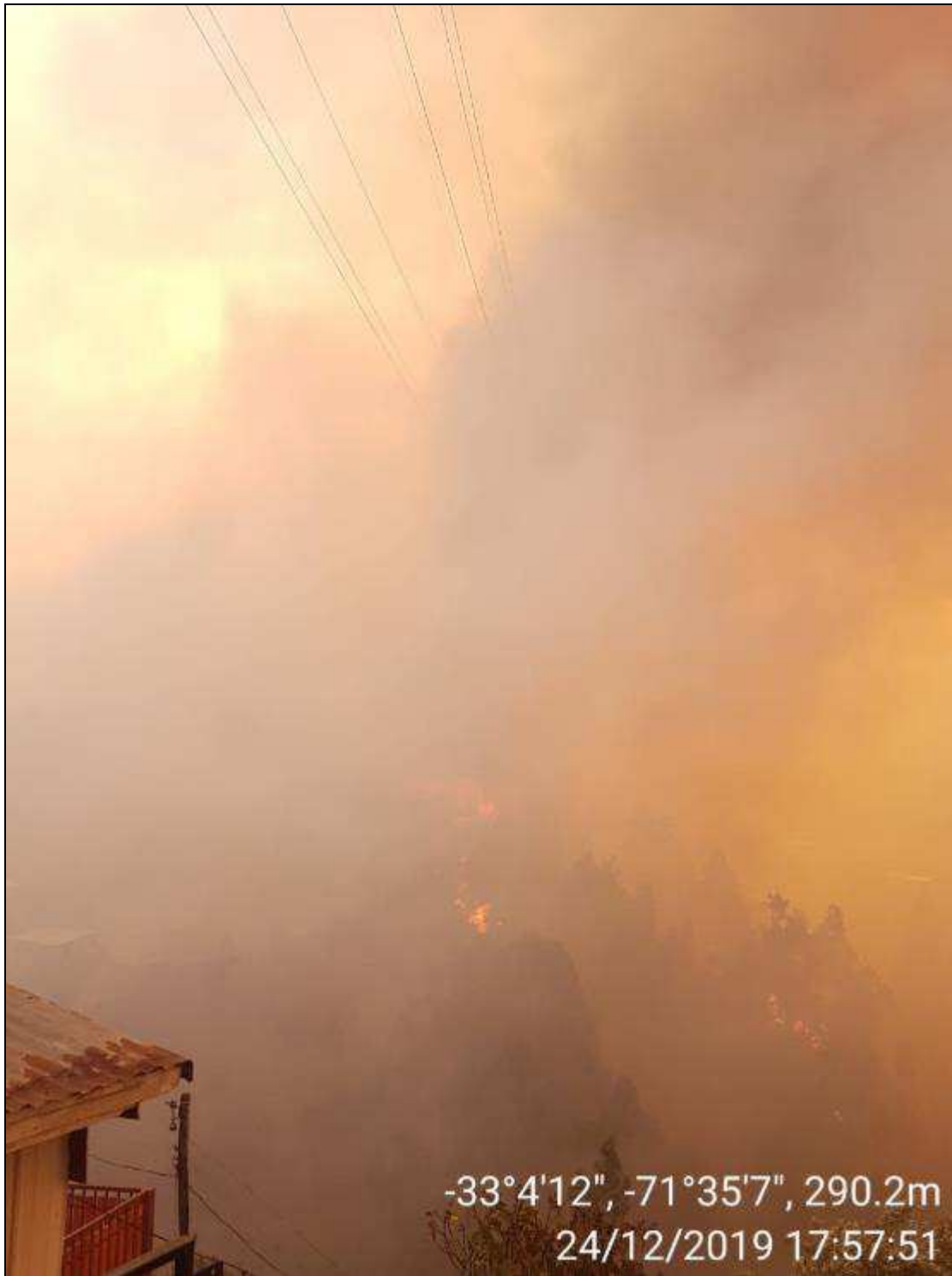
Figura 2: Línea 110 kV Laguna Verde-Agua Santa. Vista del incendio, fenómeno físico de la falla, desde la estructura N°43 hacia la estructura N°42. Columna de humo y calor afectan rigidez dieléctrica del aire y se produce cortocircuito entre conductores.
