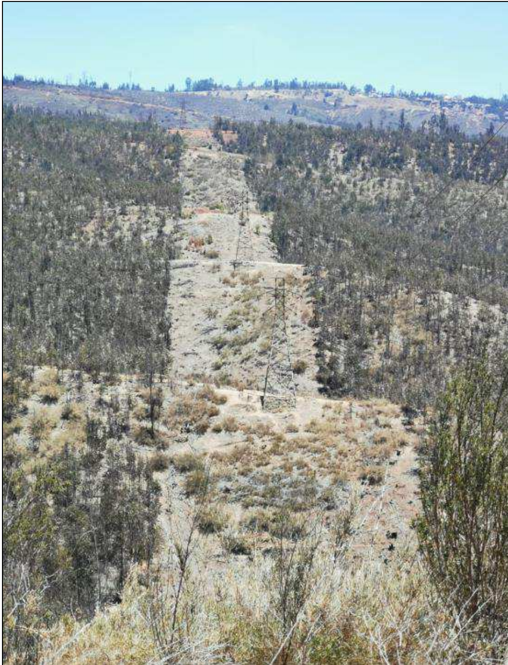
Figura 6: Franja de seguridad despejada de la Línea 110 kV Laguna Verde-Agua Santa vista desde la estructura N°39 hacia la estructura N°34. Tramo anterior a la zona del incendio.
