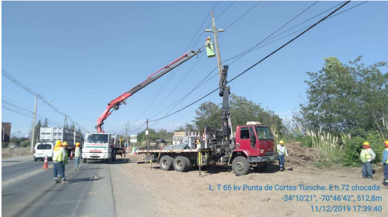
Imagen 2.- Afianzado y desmontaje de E72 para su reemplazo.
