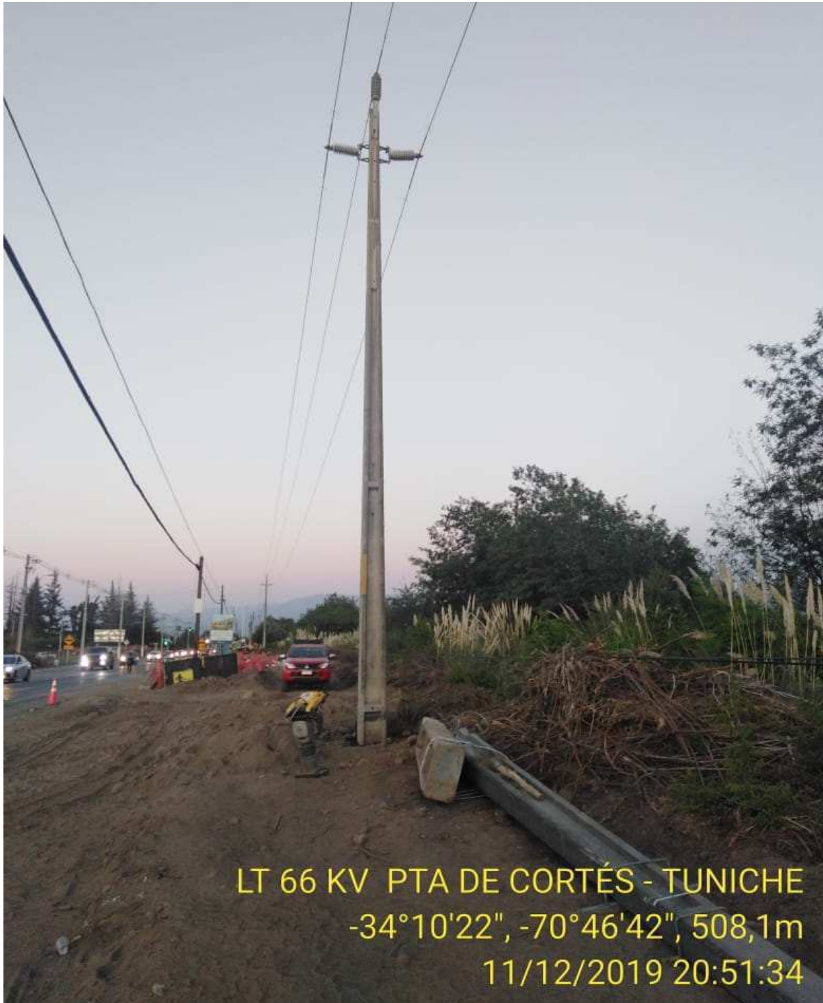
Imagen 4.- Trabajos de reemplazo E72 finalizados.
