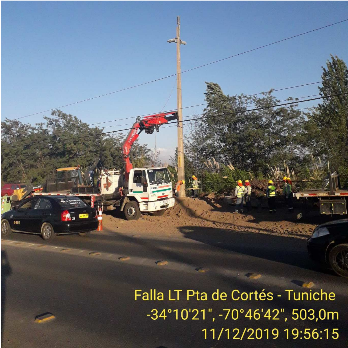
Imagen 3.- Trabajos reemplazo de la estructura N° 72.
