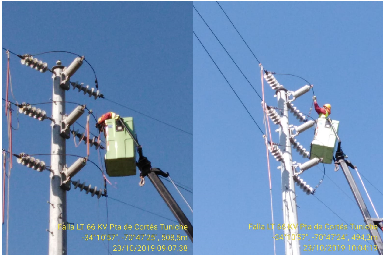
Fig. 4.- Registro fotográfico reparación puente cortado en E58
