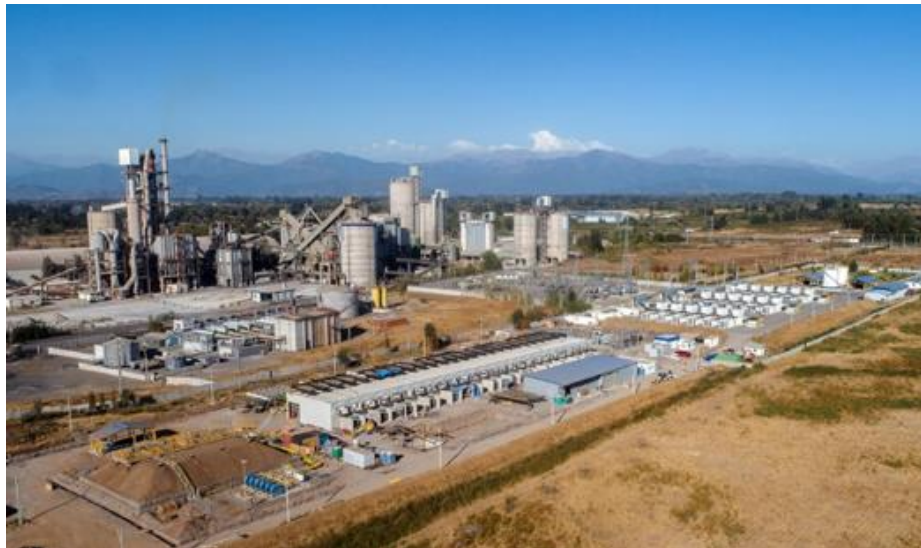
Figura 1: Vista aérea de la planta de Teno Gas 50
