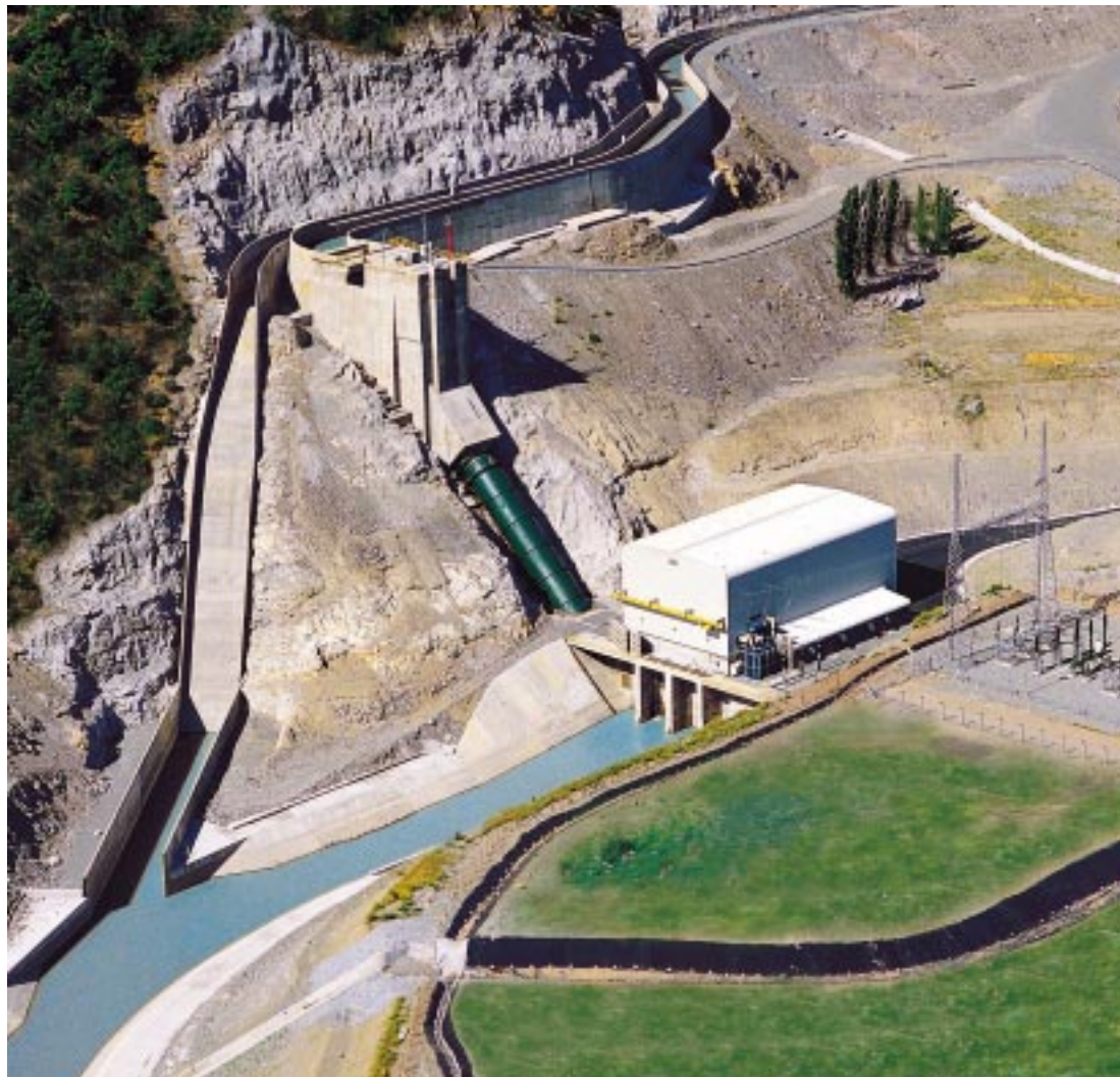
Central Hidroeléctrica Loma Alta. Potencia Instalada: 38 Mw. Ubicación: Linares, VII región.
