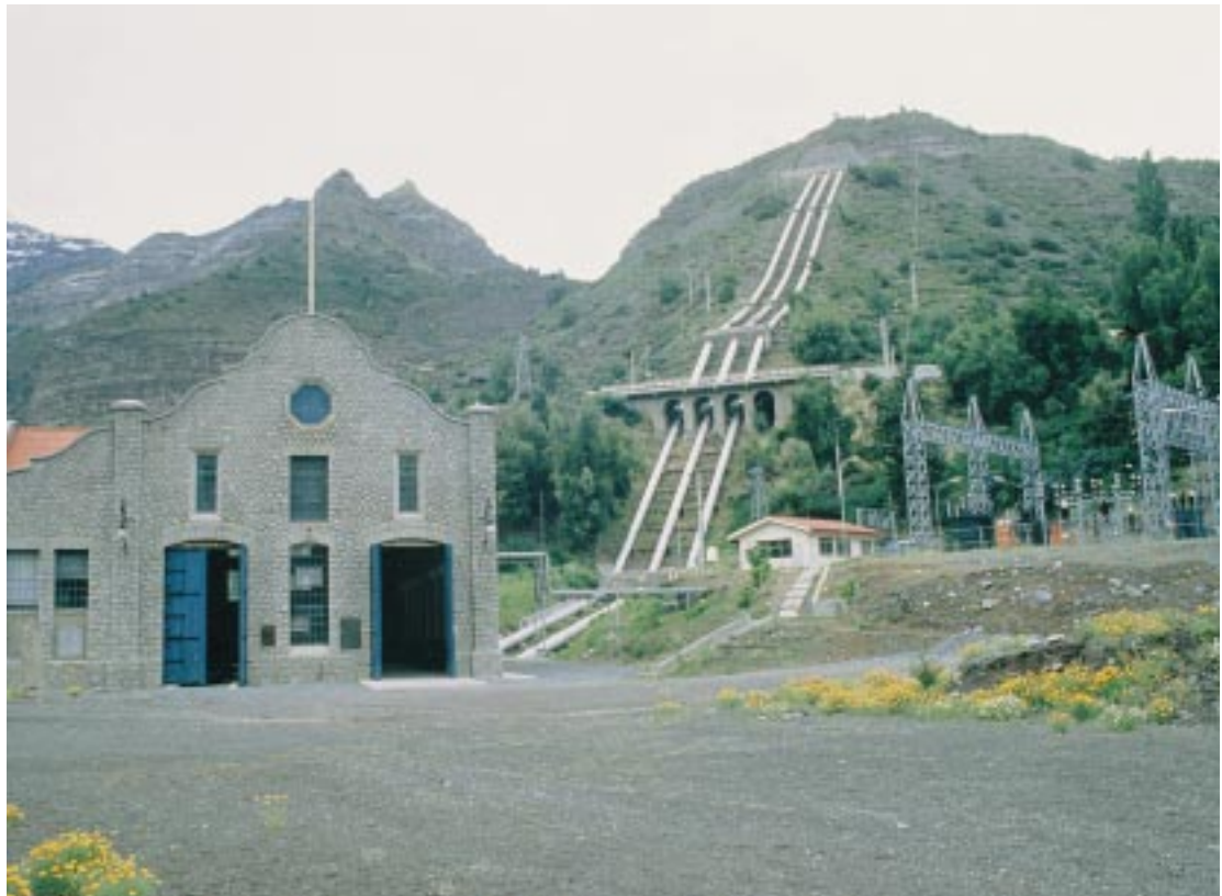
Central Hidroeléctrica Maitenes. Potencia Instalada: 30,8 Mw. Ubicación: Puente Alto, R.M.
