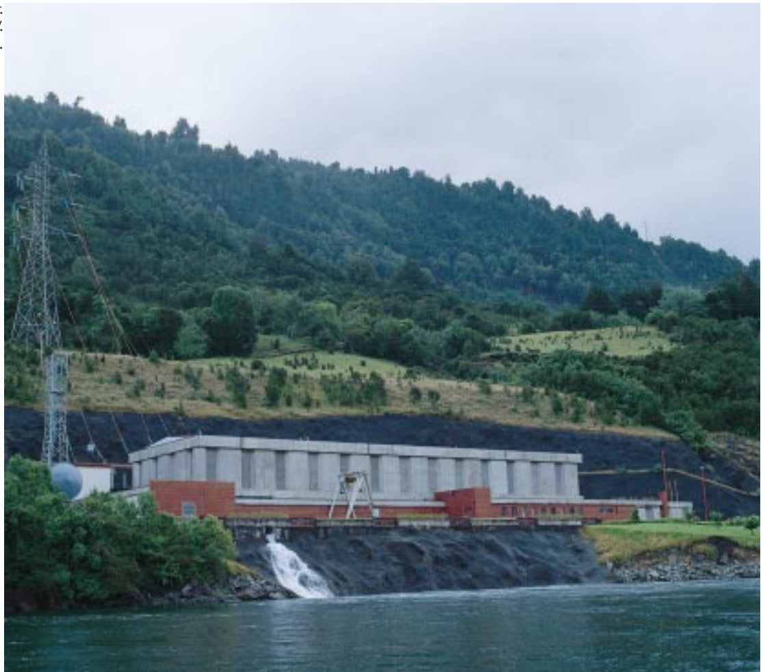
Central Hidroeléctrica Canutillar. Potencia Instalada: 145 MW. Ubicación: Pto. Montt, X región.
