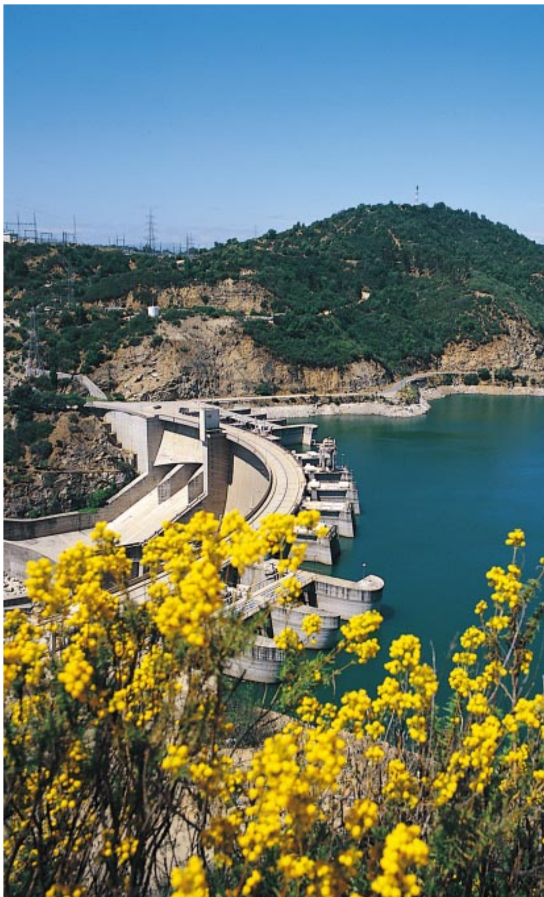
Central Hidroeléctrica Rapel. Potencia Instalada: 350 Mw. Ubicación: Navidad, VI región.
