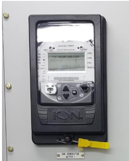
Figura 2. Medidor ION 8650 Clase 0.2
