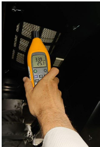
Figura 6: Medidor de temperatura y humedad ambiente situado próximo a la admisión de aire (interior container).
