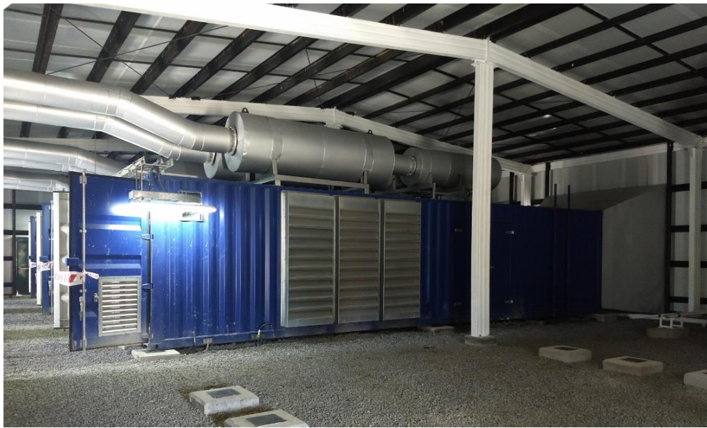
Figura 2: Interior Nave 1, Unidad 10.
