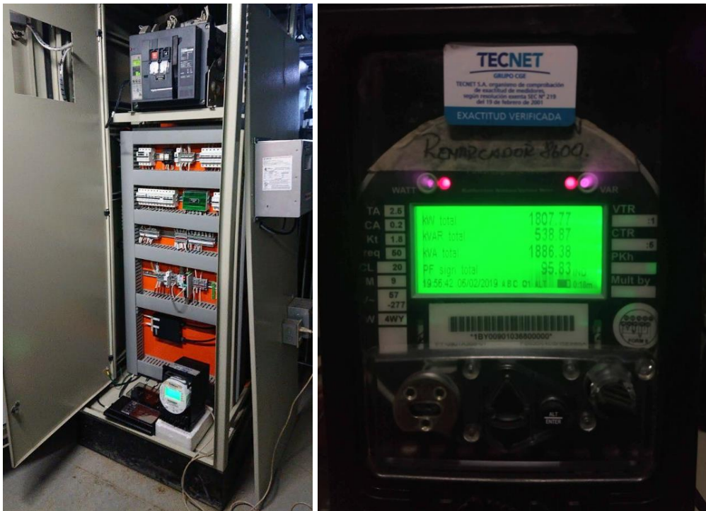
Figura 4: Instalación de medidor ION clase 0.2 en unidad representativa.
