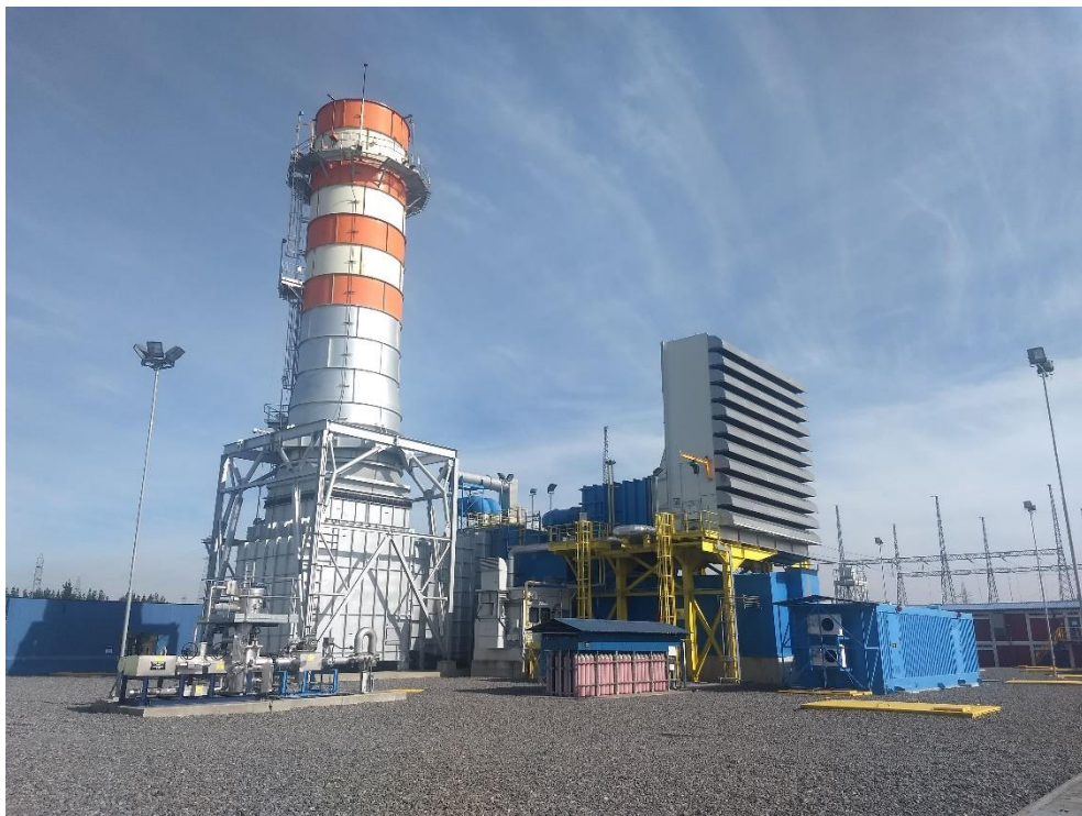
Figura 1: Central Los Guindos, vista general.
