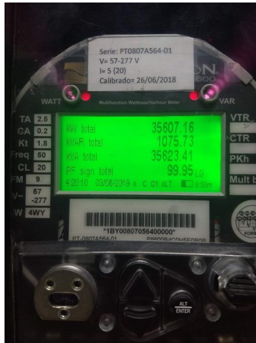
Figura 2. Medidor ION 8600 Clase 0.2
