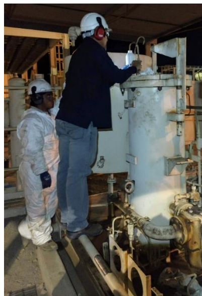
Figura 10: Toma de muestras de combustible desde arranque ubicado en filtros de combustible.
