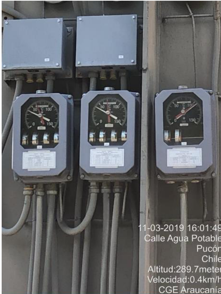
Fotografía N°2: Indicador de temperatura aceite, que continúa retenido en el mismo valor.
