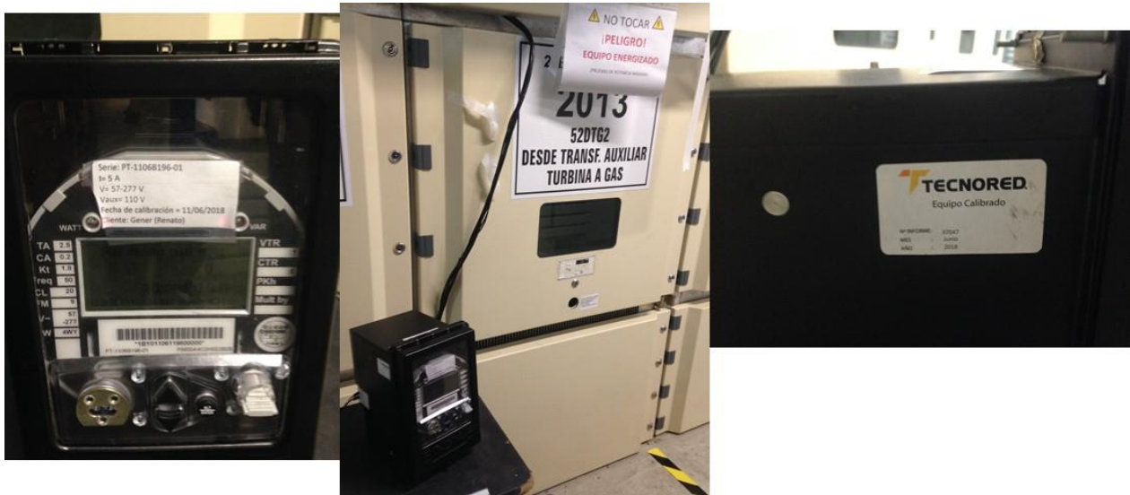
Fig. 1 Contador temporal medida consumos auxiliares TG.
