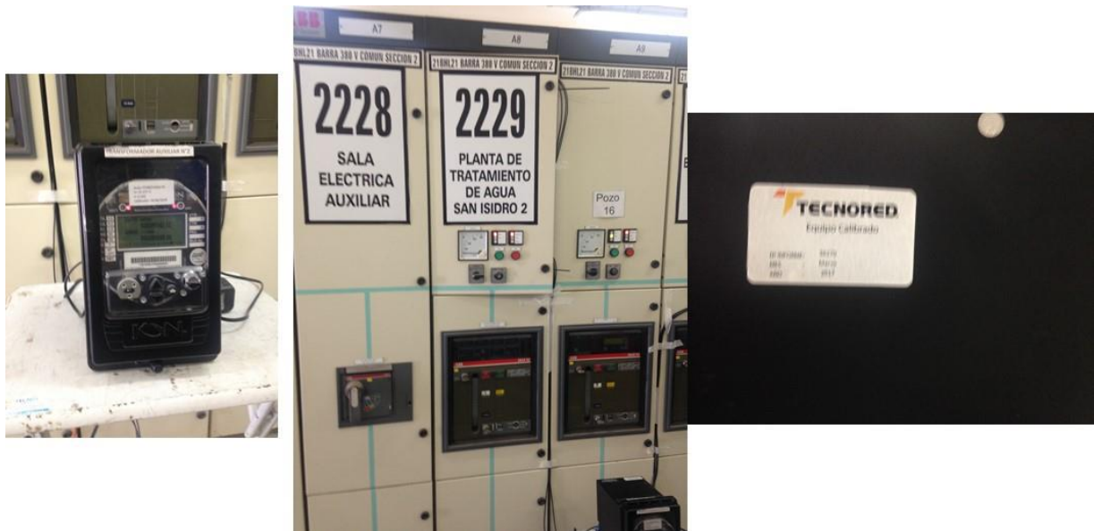
Fig. 3 Contador temporal medida consumos planta tratamiento de agua.
