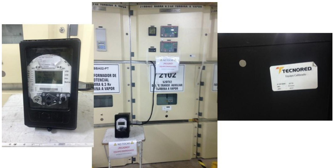
Fig. 2 Contador temporal medida consumos auxiliares TV.
