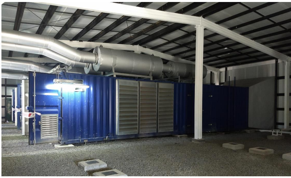
Figura 2: Interior de la Nave 1, Unidad 10.
